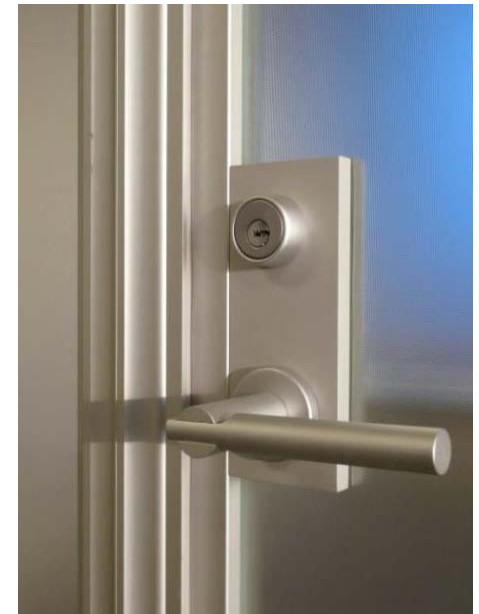
中下圖: 含鋁框玻璃門可加裝降降式氣壓條&雙層玻璃門內置惰性氣體&乾燥劑, 避免結露, 隔音佳~國內最佳複層式隔音玻璃門 右下圖: 鋁框玻璃門上實心鋁塊上加輔助鎖及水平把手示意
