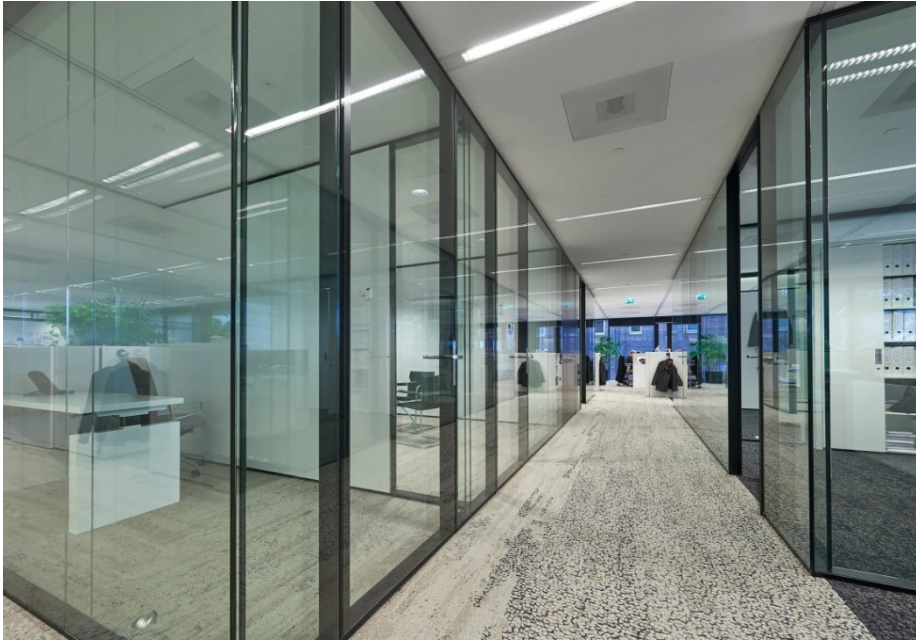
左上圖: 隔間完成厚度11.5cm~雙層玻璃, 外觀鋁合金黑色烤漆+玻璃交接無框設計 左下圖: 雙層玻璃隔間10m+12mm, 有效降低48db, 雙面矽酸鈣板面板隔音測試50db
