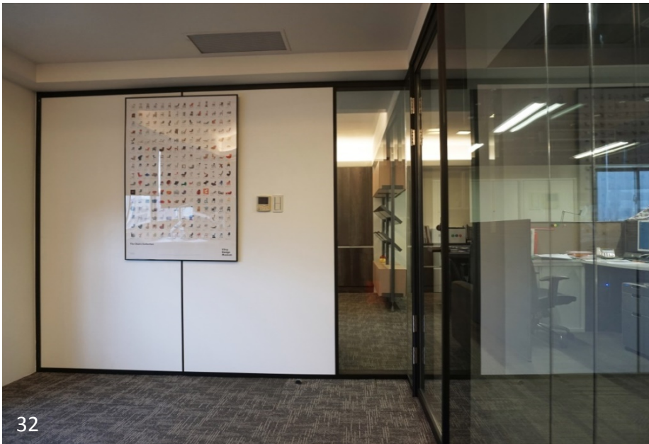
左上圖: 隔間完成厚度11.5cm~雙層玻璃, 外觀鋁合金黑色烤漆+玻璃交接無框設計 左下圖: 雙層玻璃隔間10m+12mm, 有效降低48db, 雙面矽酸鈣板面板隔音測試50db
